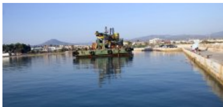
Vrakhati en travaux
