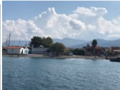
Accès au port et à la cale du chantier
