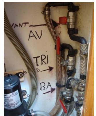
Vannes alimentation eau : ici seul TRI est ouverte
